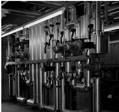
ATV 12 sterowanie stacji pompowej
