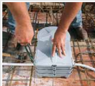
Dodatkowo przymocuj obudowę do zbrojenia.
