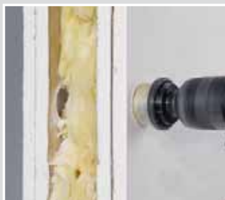
Wykonaj otwór instalacyjny 35 mm za pomocą otwornicy Multi 4000 (art. 1082-10).
