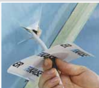
Wsuń wpust na kabel lub rurę.
