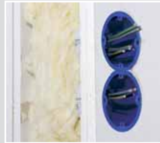
Jednostronne zastosowanie zestawu dwóch puszek z izolacją akustyczną.
