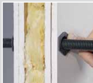
Wciśnij przepust z rurą do otworu i zamocuj etykietę identyfikacyjną.
