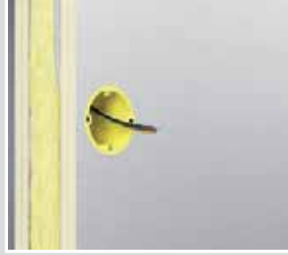
Montaż puszki chroniącej przed promieniowaniem w ścianie.
