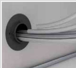
Wprowadź nowe kable i rury elektroinstalacyjne.
