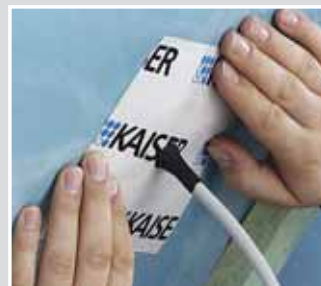
Naklej przepust na podłoże i wyrównaj, wyglądając od środka na zewnątrz.
