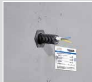
Przepust w ogniowej ścianie betonowej.
