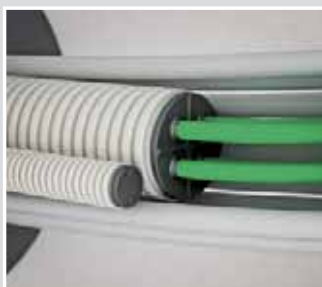
Zamknij końce rur elektroinstalacyjnych (np. dymoszczelną zaślepką uszczelniającą KAISER).
