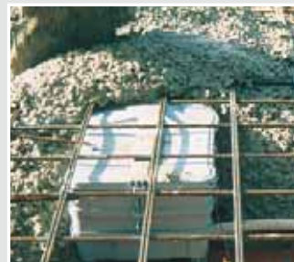
Bezpiecznie osadzona obudowa podczas zalewania betonem.
