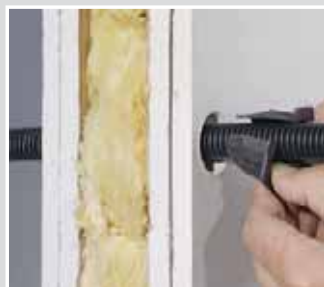
Otwórz przepust wzdłuż nacięcia i nałóż go na rurę.
