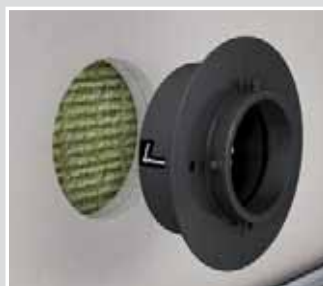
Umieść wkładkę pęczniącą w otworze.
