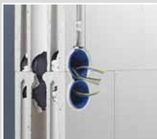
Izolowane akustycznie puszki osadzone przeciwległe po obu stronach ściany.
