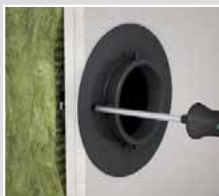
Zamocuj wkładkę przykręcając ją do ściany (tak jak w przypadku puszek w ścianach szkieletowych).
