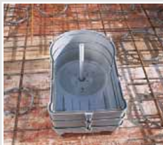
Zamocuj do szalunku obudowę z 2 ramkami pośrednimi i wspornikiem rurowym.
