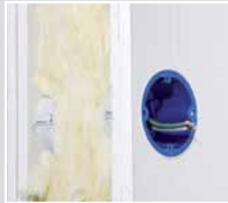
Zastosowanie przeciwnych puszek z izolacją akustyczną.
