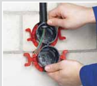
Wsuń do niego puszkę z zamocowanym pierścieniem KLEMMFIX®.
