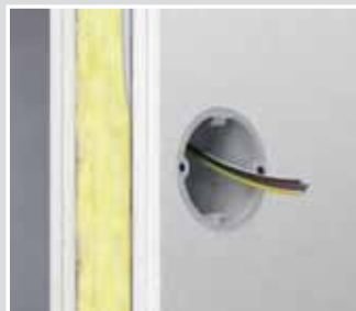
Montaż puszki chroniącej przed promieniowaniem w ścianie.
