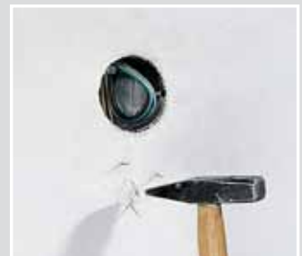
Cienkie wążki na pokrywie sygnalizacyjnej dokładnie wskazują położenie puszek po otynkowaniu ściany.
