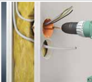
Można wykorzystać istniejące otwory instalacyjne Ø68 mm
