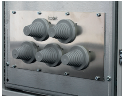
Przepusty kablowe na ścianie działowej szafy Rittal TS 8 przy zastosowaniu płyty modułowej
